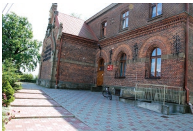
Az általános iskola épülete
