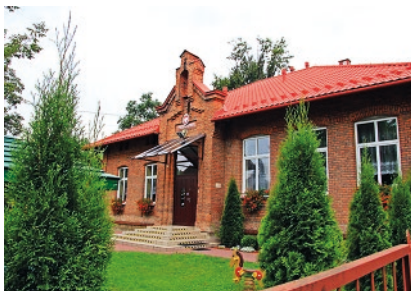
Az óvoda épülete
